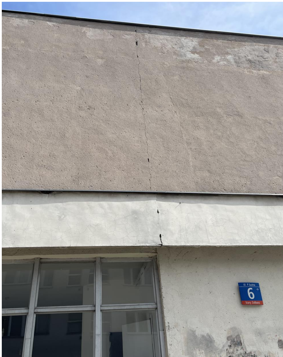
Fot. 3 zarysowana ściana od strony zachodniej
