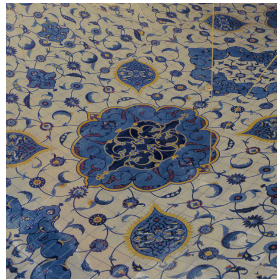
Fragment sklepienia wyłożonego ręcznie malowanymi kafłami.
