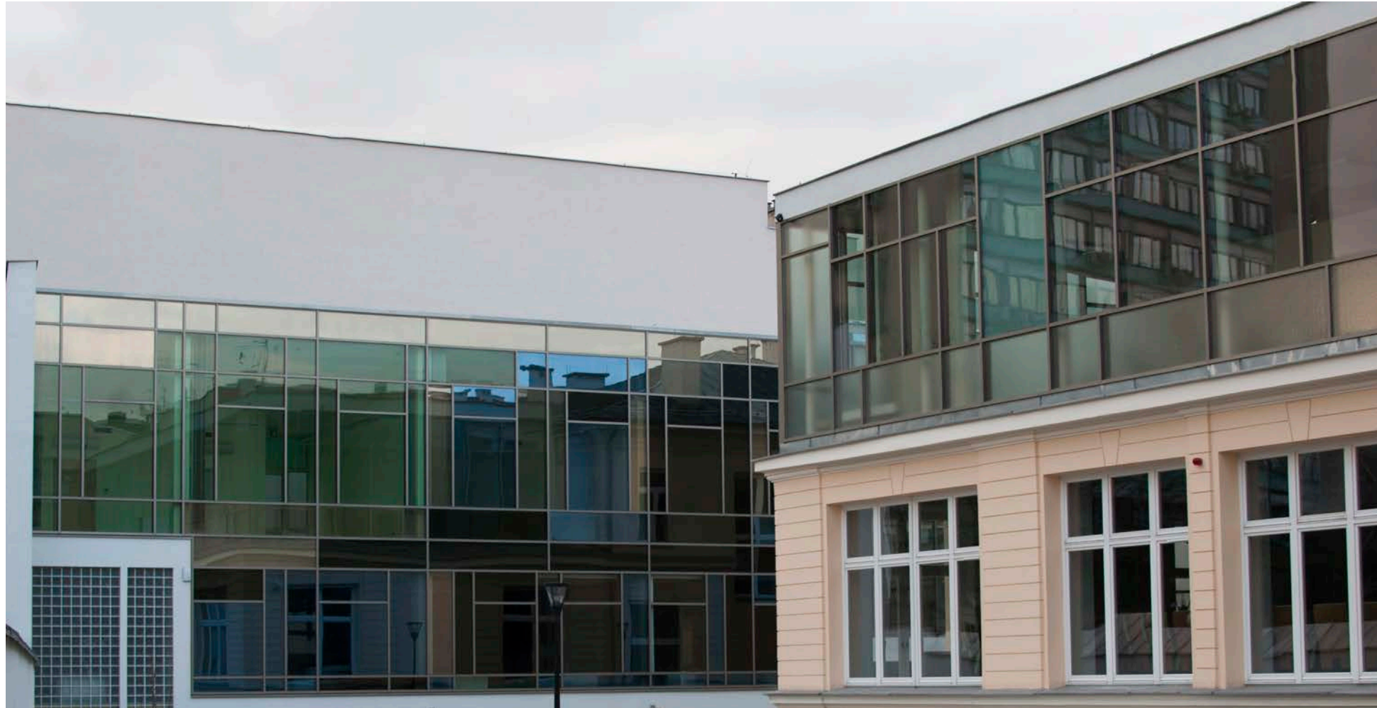
Malarskie powidoki. Elewacja nowej oficyny Pałacu Morskich w Lublinie jest próbą przełożenia wartości malarskich na architekturę.
